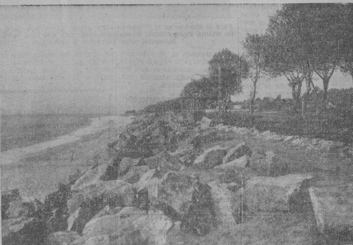
Consruccion de escolleros, otra de las facetas de Hijos de José Miarnau Navas, S. A. He aquí un detalle de defensa contra el mar en el litoral mediterráneo, en el tramo Mataró-Malgrat, próximo a la vía férrea.
