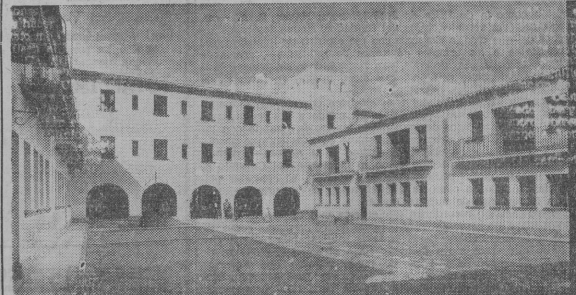
En la construcción de edificaciones, cuenta también la destacada firma contratista de obras públicas, con una ingente labor. He aquí un aspecto del cuartel de la Guardia Civil de Mora, cuyo edificio fué encomendado a la casa Hijos de José Miarnau Navas, S. A.
