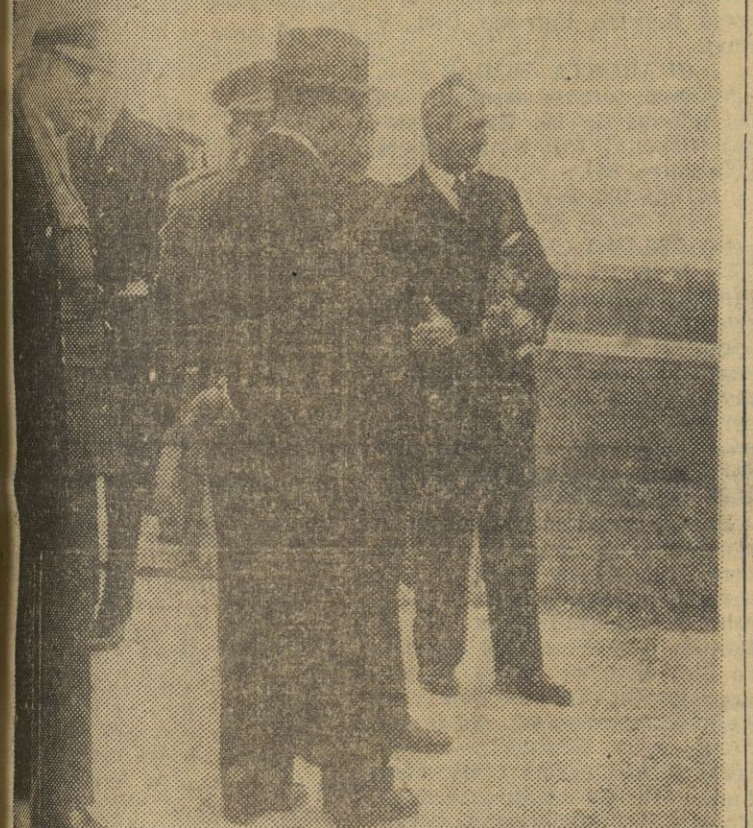
SEVILLA. — S. E. el Jefe del Estado durante su visita a las obras de construcción del sifón del Guadaira, del Canal del Bajo Guadalquivir. — (Foto Cifra).
