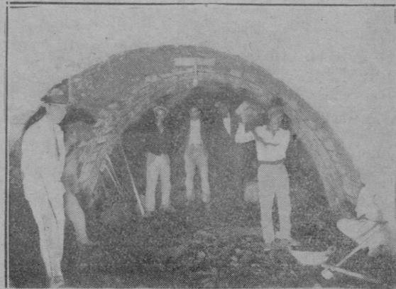
Construcción de un anillo y en el fondo la galería de avance.
