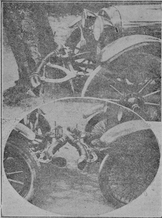
EL NUEVO INVENTO DE LA MECANICA.—El parachoques alemán para automóviles.— De abajo a arriba: El parachoques de caucho probando su eficacia en la colisión con un árbol en el cual el coche no sufrió la menor avería. Prueba del nuevo parachoques de caucho en una colisión de dos autos en el que demostró una vez más sus buenos resultados.
