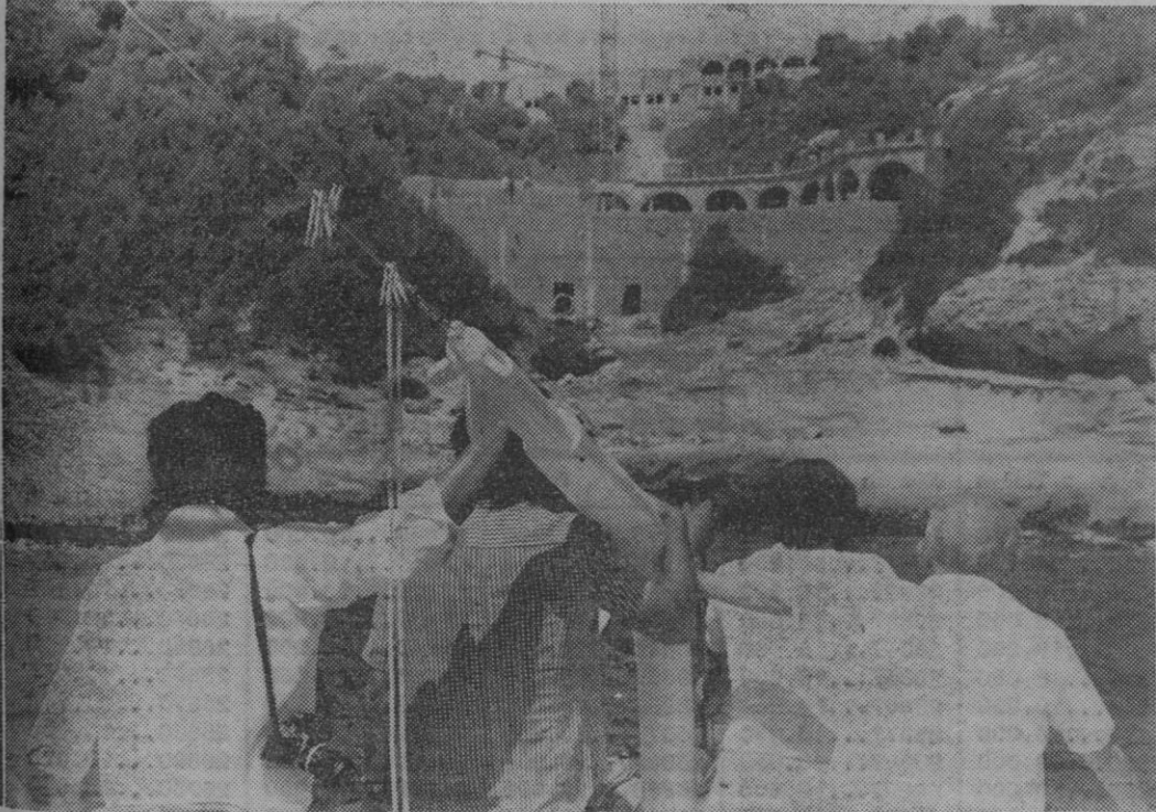
Las obras del Casino definitivo, en Cala Xada. Se sigue trabajando a un ritmo muy acelerado, y se espera que a finales de año pueda ser inaugurado oficialmente. La fotografía está tomada desde el mar.
