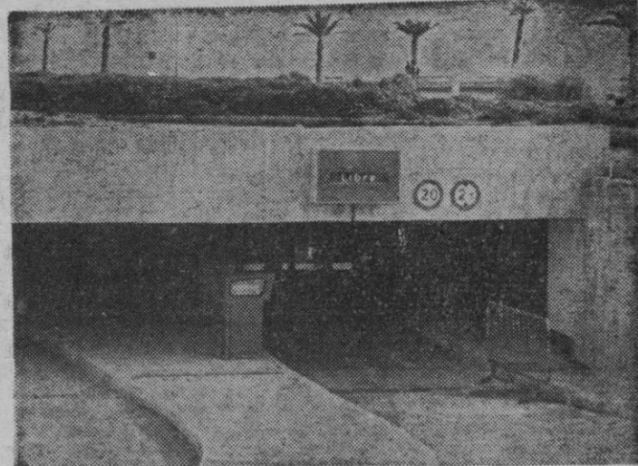
En el Parque del Mar, un «parking» que no se utiliza.
