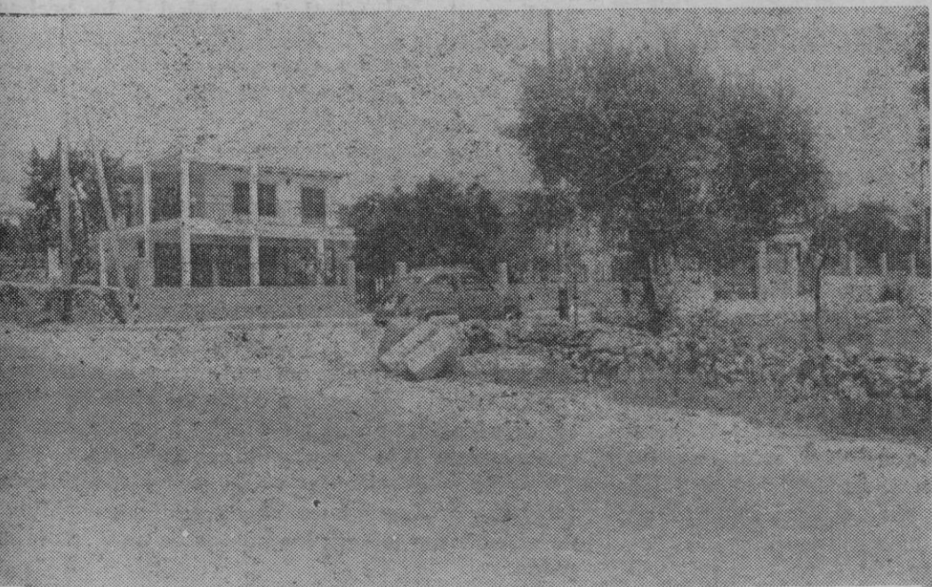
La Cabaneta contará junto con Portol de una planta depuradora de aguas residuales en fechas próximas.
