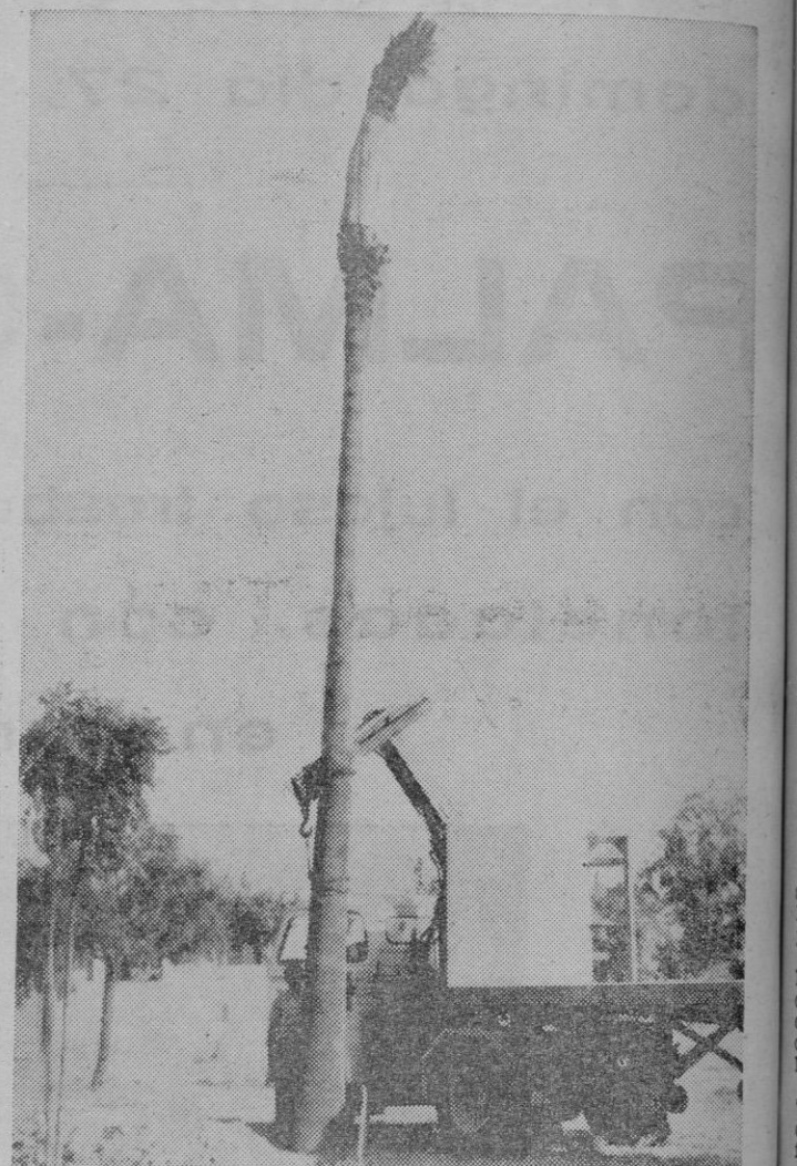
Momento en que la grúa coloca la preciosa palmera gigante en el hoyo de trasplante del futuro Parque de Recreo.
