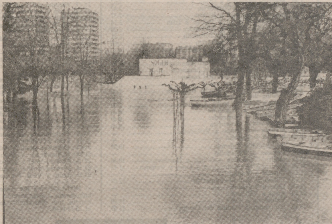
Las inmediaciones de las Piscinas, totalmente anegadas.
