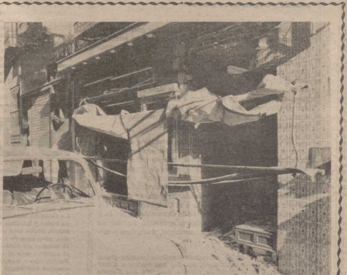
EXPLOSION MADRID. — Destrozos en la portada de un establecimiento dedicado a la venta de prendas de confección para trabajo, sito en la calle Jordán, a causa de la explosión de un artefacto en la madrugada de ayer. (Foto Cifra Gráfica.)
