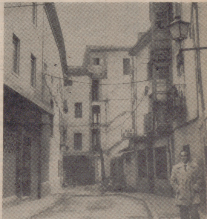
El callejón de la Caridad, viejo lugar típico de nuestra ciudad, desaparece al ser cerrado para realizar obras con vistas a nuevas edificaciones. Es el progreso, inevitable, con su regusto agrídulce.
