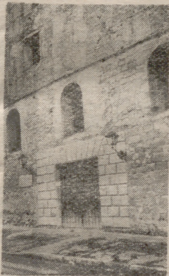
El futuro emplazamiento del Conservatorio.
