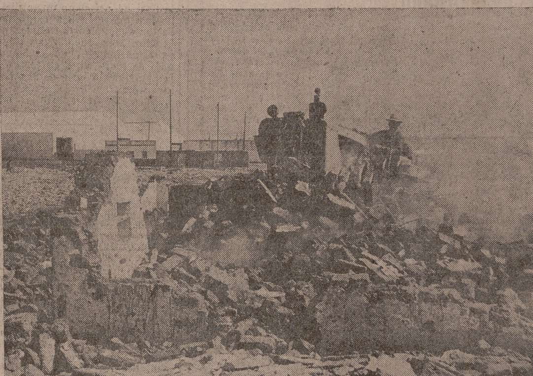
SEVILLA — Después de que el señor Sánchez Arjona prendiese fuego a las últimas chabolas del suburbio El Vaco, los tractores van demoliendo estas miserables viviendas, y una vez el solar de ellas quede limpio de escombros, se procederá a la construcción de un bloque de mil seiscientas cuarenta viviendas de renta limitada que serán entregadas entre julio y septiembre del próximo año. — (Foto Cifra Gráfica).
