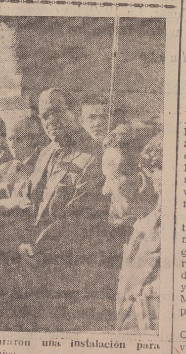
Momento de la bendición de las nuevas obras. En Ventosa se inauguraron una instalación para abastecimiento de agua y una central telefónica.
