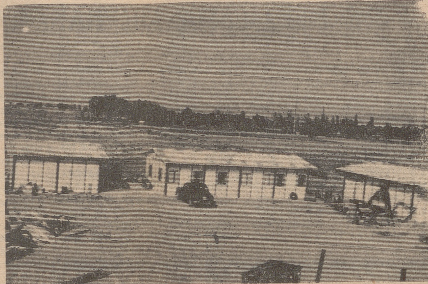
Oficinas de Santo Domingo de la Calzada. Obra del canal del Najerilla.
