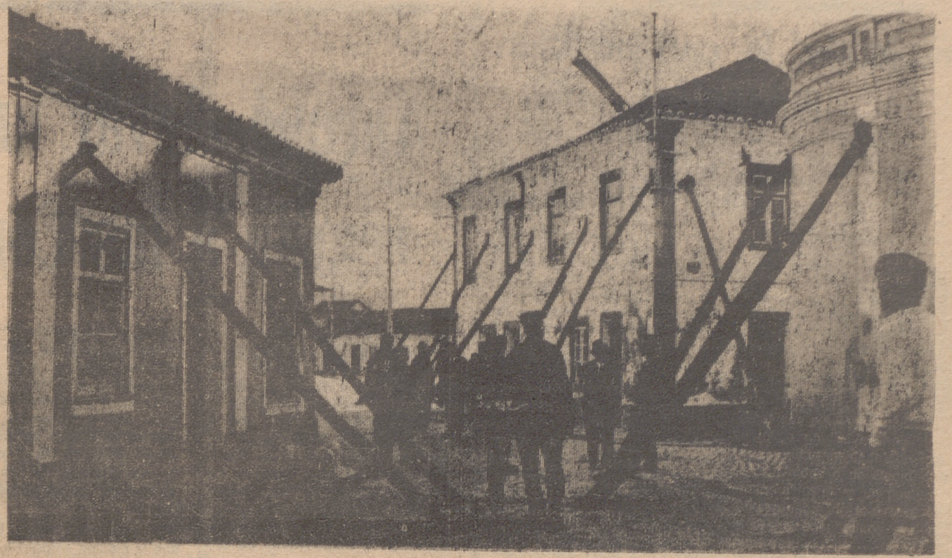
PORTIMAO (Portugal). — Edificios apuntalados a causa de los efectos del temblor de tierra que se dejó sentir en la madrugada del pasado día 28. Esta localidad pertenece a la región del Algarve, al Sur de Portugal. — (Telefoto «Upi-Cifra»).
