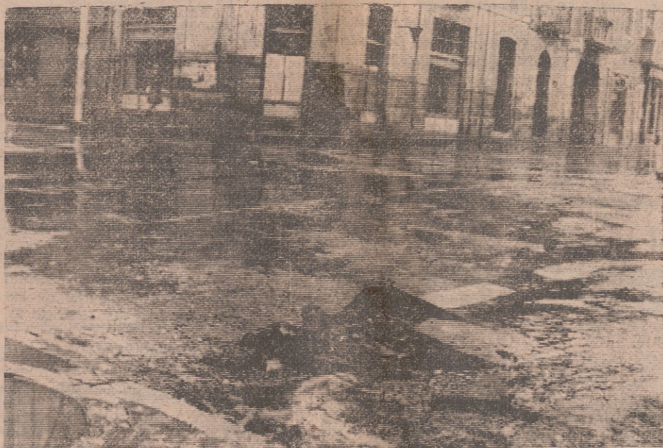
En el cruce Mola Once de Julio y Murrieta se produjo un monumental chispazo eléctrico y un daño consiguiente en la red de tuberías de agua, que dejó en este estado el pavimento. — (Foto "Albe").
