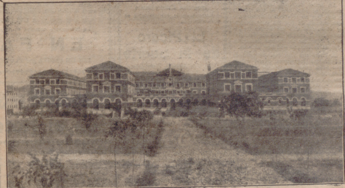
VISTA DE LA PARTE POSTERIOR DEL NUEVO EDIFICIO (Fot. San Salvador)
