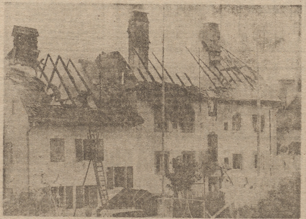
Los bomberos sofocan las últimas llamas de las tres casas incendiadas en La Sagne (Suiza) por dos niños que jugaban con unas cerillas. El viento propagó el fuego rápidamente. El resultado y balance del siniestro ha sido: diez familias sin hogar, tres casas destruidas y otras tres dañadas. (Fotofiel.)
