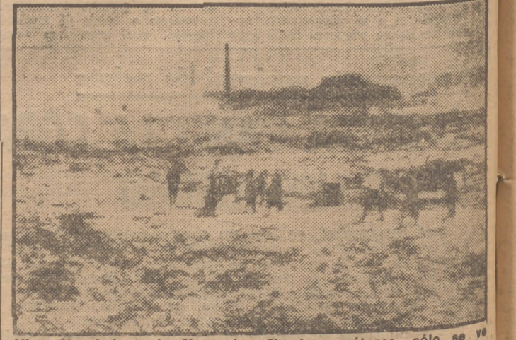
Vista desoladora de Nagasaki. No hay cráteres, sólo se ve una extensísima zona totalmente arrasada.
