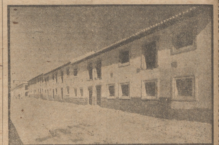
Estado de las obras en construcción del grupo de 200 viviendas protegidas denominado Bermúdez de Castro (segunda fase.) (Foto Torres Molina.)
