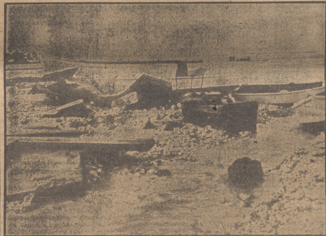
Olas gigantes azotaron la costa de Honolulu y el Pacífico ofreció un fenómeno poco conocido que todavía estudian los observadores y que causó muchas muertes y destrucciones catastróficas. La Prensa de todo el mundo dió toda clase de detalles sobre el suceso y hasta hubo quien trató de atribuirlo a supuestas pruebas de la bomba atómica. La fotografía muestra una parte del canal de Ala Wai con los destrozos originados por el oleaje. (Foto A. P.)
