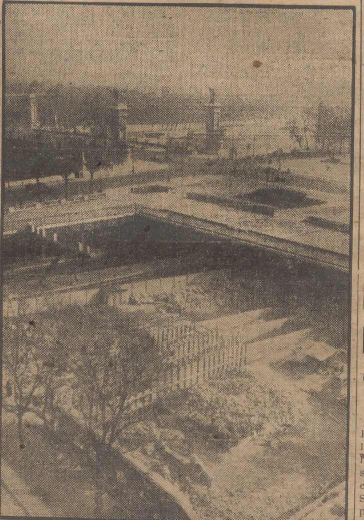
Están en plena actividad los trabajos en la estación de los Invalidos, de París, para transformarla en un aeródromo espacioso dotado de todas las ventajas técnicas modernas y las mayores comodidades para los viajeros. Al fondo se ve el puente de Alejandro III. (Foto Cifra.)
