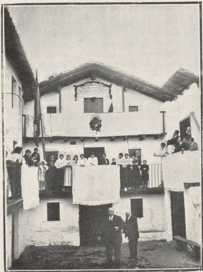
Casa donde nació el Sr. Arechavaleta
