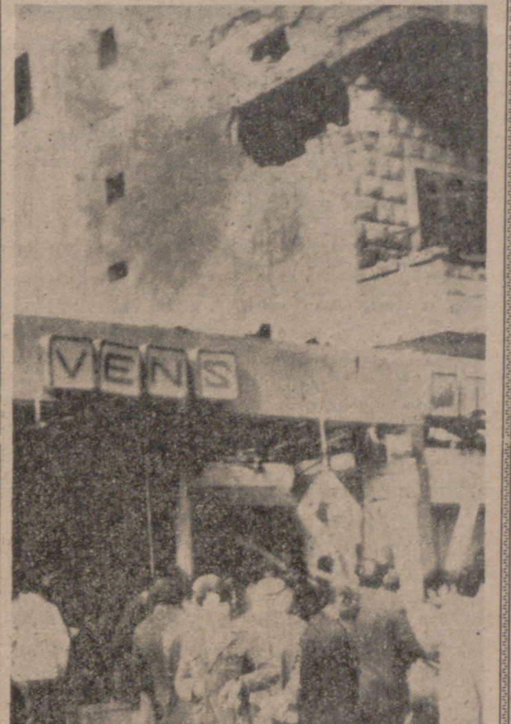
NABATIYEH (Libano).—Un edificio de esta localidad presenta los destrozos causados por la artillería israelí durante el ataque lanzado la noche del jueves.—(Telefoto Cifra Gráfica.)
