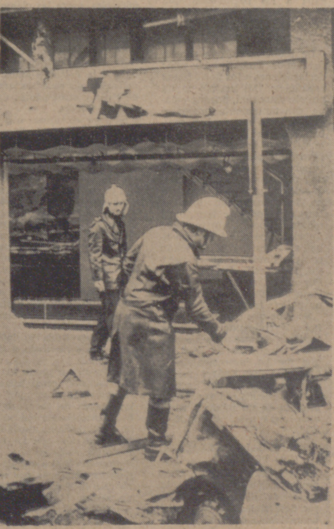
BRUSELAS.—Una bomba colocada en el interior de un coche hizo explosión ayer por la mañana, ocasionando daños en diversos establecimientos próximos, entre ellos las oficinas de la Compañía «Iberia». Un transeúnte resultó herido. La foto muestra los destrozos ocasionados en el lugar de la explosión. — (Telefoto Cifra Gráfica-Upi.)
