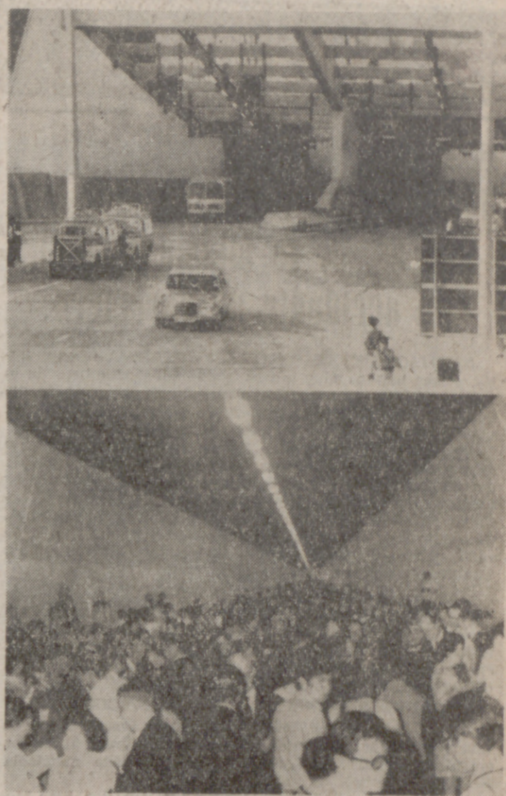
HONG-KONG.—El túnel a través de la bahía, bajo la bahía Victoria, que une la isla de Hong-Kong con la península de Kowloon y que ha costado cincuenta millones de dólares, ha sido inaugurado oficialmente. No se permite (arriba) que los vehículos atraviesen el túnel enteramente, sino que circulan hasta el centro. Abajo, durante la ceremonia inaugural se ofreció champaña a los invitados. El túnel, de cuatro calles, tiene una longitud de 1.600 metros, con capacidad de paso para 70.000 vehículos diarios. (Telefoto Cifra Gráfica-Upi)
