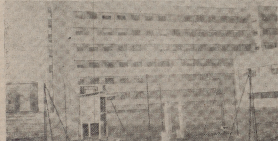
Instalaciones exteriores del Centro Meteorológico del Duero. En primer plano, el abrigo meteorológico, pluviómetro y pluviógrafo.
