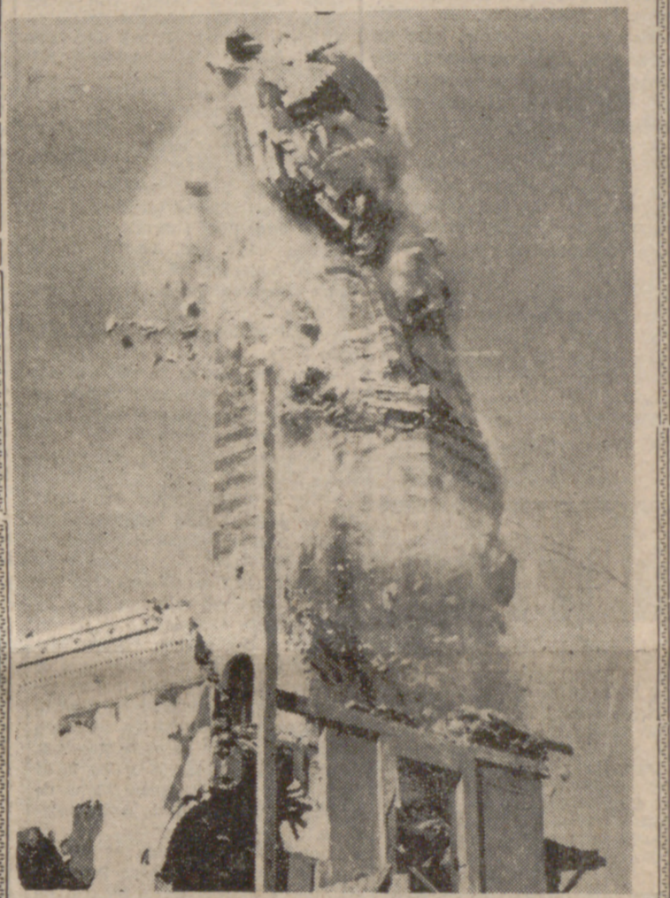
Esperando el acontecimiento del derribo de la vieja torre del Ayuntamiento, gran número de gente se congregó en la Plaza Mayor. El último vestigio del antiguo Ayuntamiento ha sido totalmente derribado, y muy pronto comenzarán las obras del nuevo edificio, en el que se reunirán todos los servicios de la ciudad: Oficinas municipales, Juzgados, Correos, Telégrafos, etcétera. Será un Ayuntamiento moderno y funcional, con castellana fachada. Esta estupenda fotografía —por su oportunidad y claridad— ofrece el momento en que la torre cae a tierra. (Foto Barrios)
