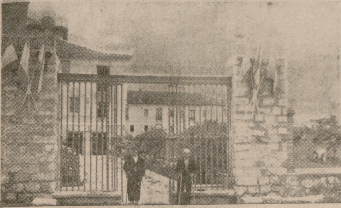
Entrada al Hospital Casa Asilo de Ancianos.
