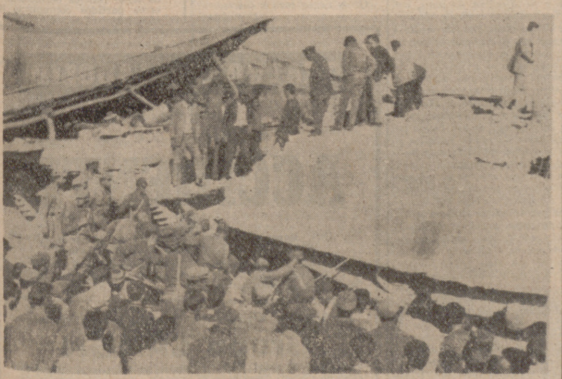
DIMGOL (Turquía).—Los equipos de rescate ante las ruinas de uno de los edificios derrumbados en esta ciudad a causa del terremoto que sacudió el día 22, en el que se calcula ha habido un millar de víctimas.—(Telefoto Cifra Gráfica.)
