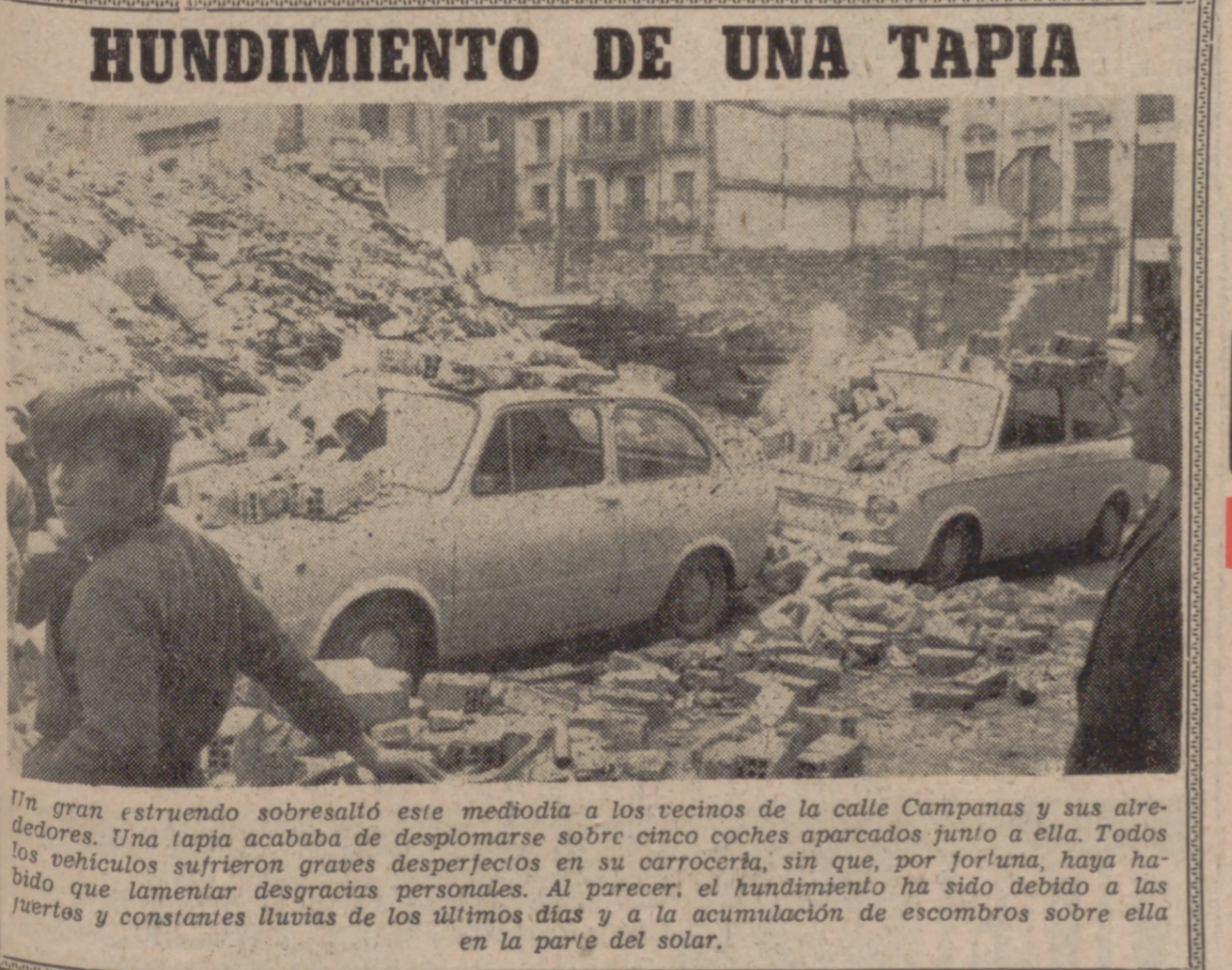
Un gran estruendo sobresaltó este mediodía a los vecinos de la calle Campanas y sus alrededores. Una tapia acabada de desmoronarse en su carrocería, sin que, por fortuna, haya habido que lamentar desgracias personales. Al parecer, el hundimiento ha sido debido a las fuertes y constantes lluvias de los últimos días y a la acumulación de escombros sobre ella en la parte del solar.
