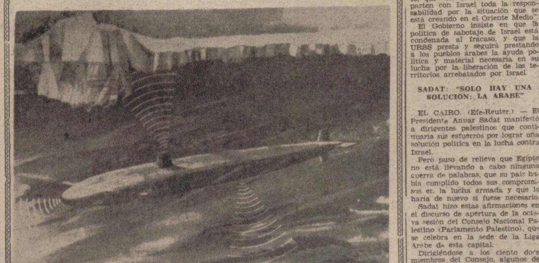
SAN DIEGO.—Diseño artístico en el que se muestra a un submarino nuclear navegando bajo el hielo en el Ártico, transportando gasolina desde Alaska a los puertos helados del Atlántico Norte. Dicho sistema de submarino-cisterna ha sido propuesto como un medio económico y seguro para dicha clase de transporte, capaz de suministrar 1,8 millones de barriles en dos semanas.—(F. Cifra.)
