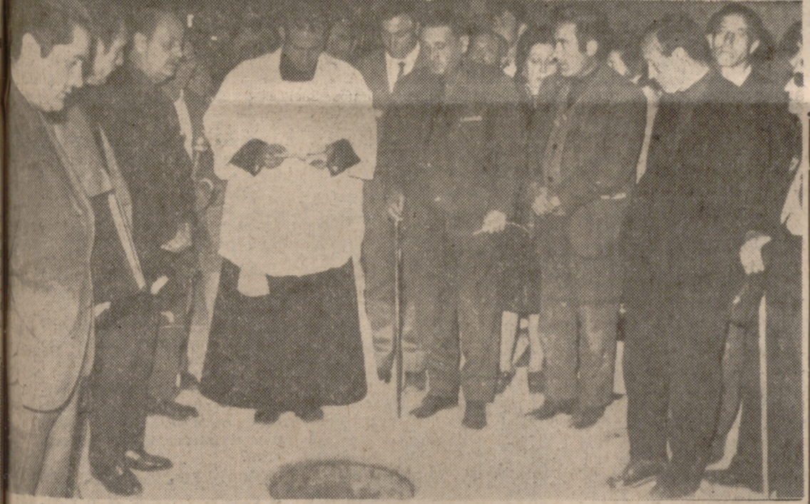
Inauguración del alcantarillado de Mucientes.
