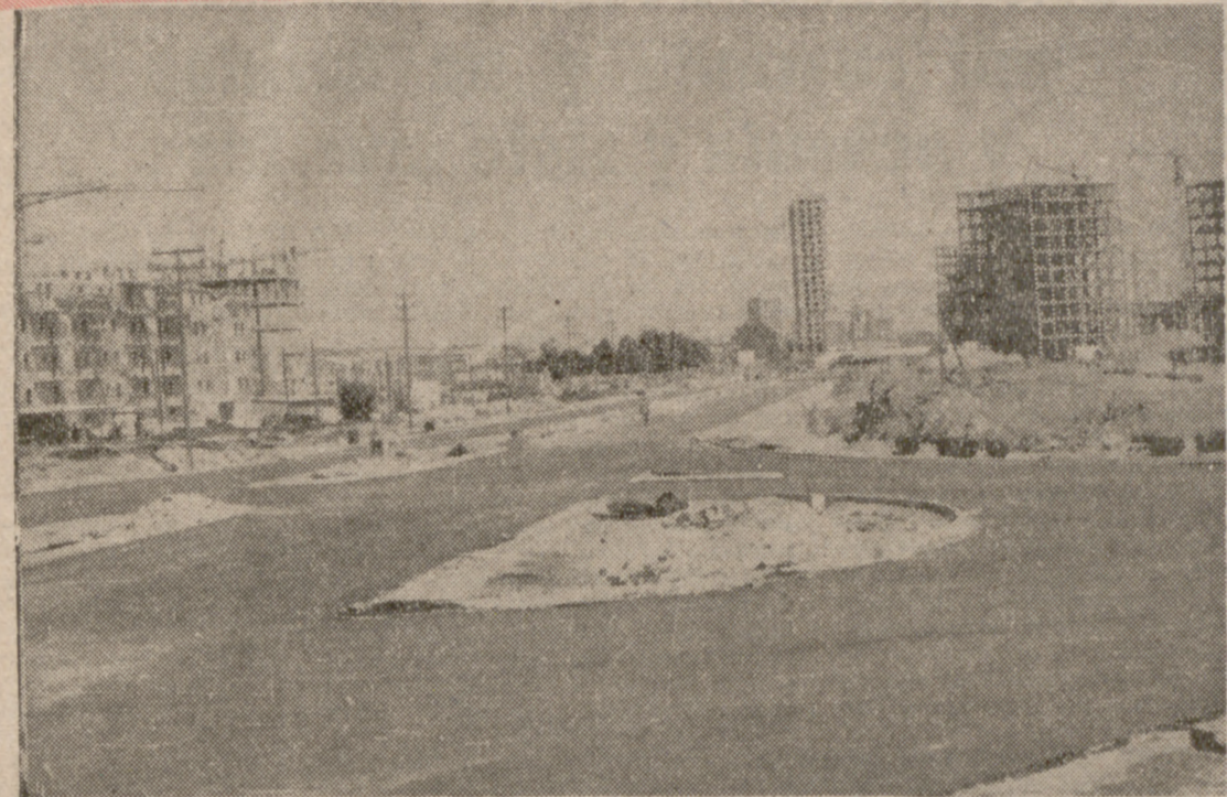
La carretera de la Olma, durante las obras.
