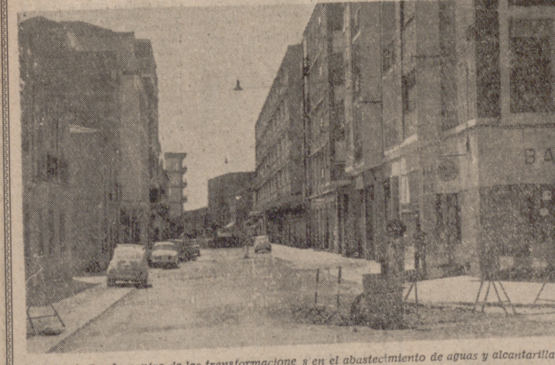
La calle de Rueda, centro de las transformaciones en el abastecimiento de aguas y alcantarillado.
