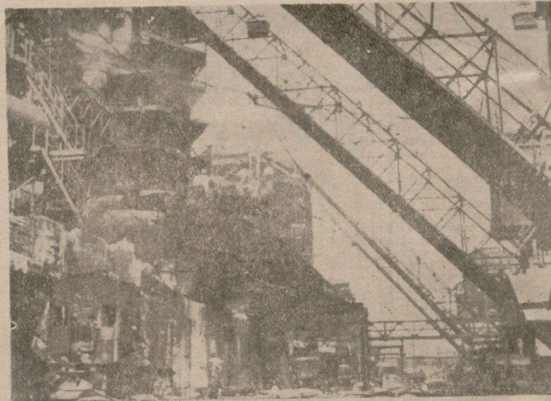
La siderúrgica de Yawata, considerada la sexta del mundo, con una producción actual de 9,5 millones de toneladas de acero.
