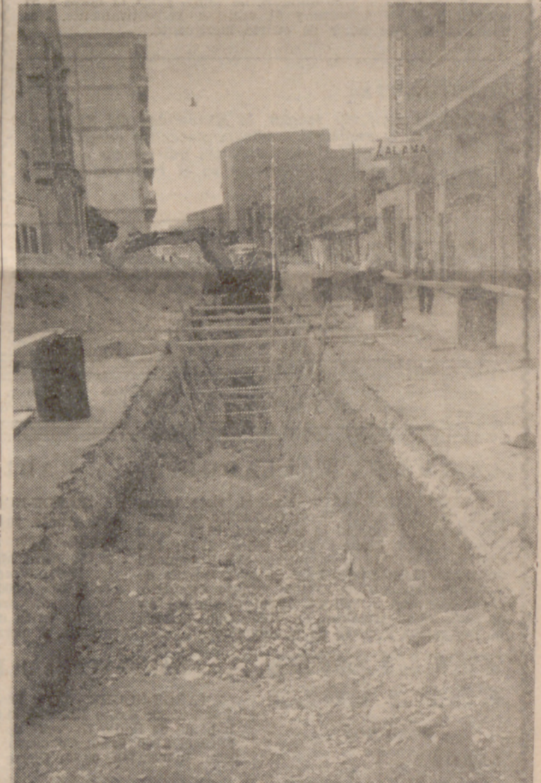
Vista de las obras de alcantarillado de la carretera de Rueda.
