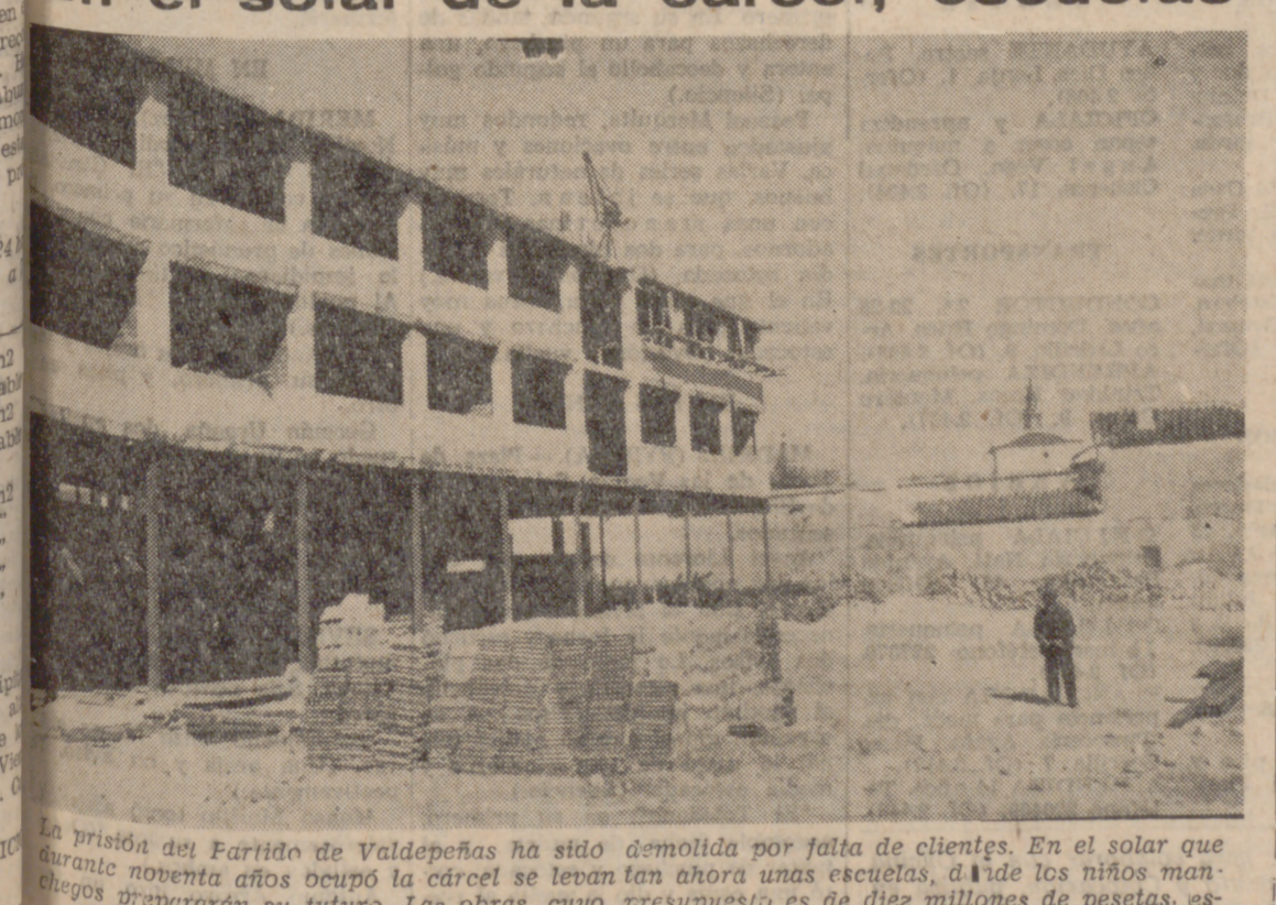
La misión del Partido de Valdepeñas ha sido demolida por falta de clientes. En el solar que durante noventa años ocupó la cárcel se levantan ahora unas escuelas, desde los niños manchegos prepararán su futuro. Las obras, cuyo presupuesto es de diez millones de pesetas, están ahora así.—(Foto PYRESA.)
