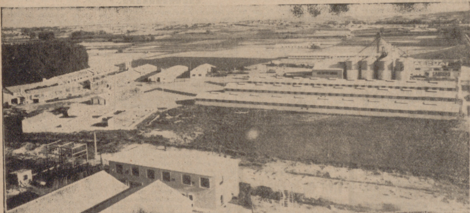
VISTA PARCIAL DE UNA DE LAS INSTALACIONES
