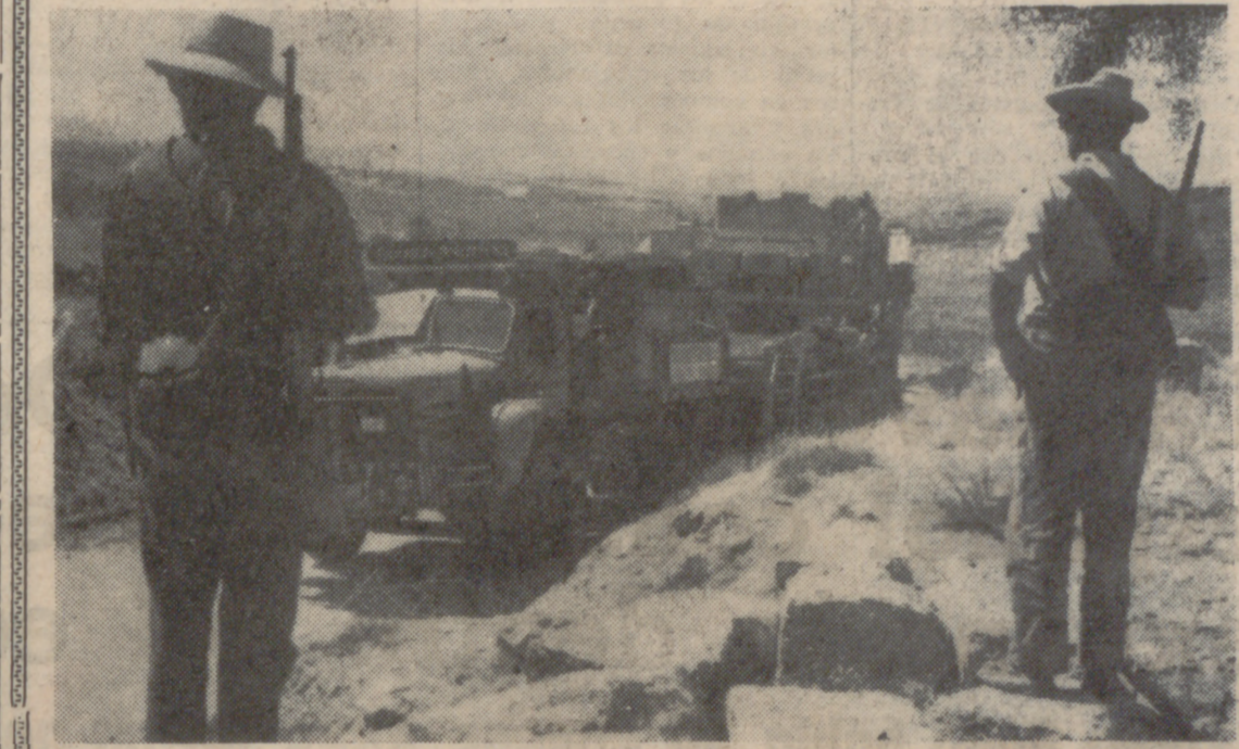
Por tierras de Cuenca avanza el convoy que transporta a la Central Nuclear de Zorita la pieza del reactor, una de las tres enormes piezas que han de llegar a la Central. El imponente conjunto recorre unos cuatro kilómetros a la hora. En la fotografía, una vista del remolque que va acompañado además de dos tractores que no se pueden apreciar. El remolque tiene 56 ruedas, todas articuladas y con suspensión independiente. Para que no existan obstáculos en el tránsito de la gran mole, ha habido que hacer un extenso acondicionamiento del trayecto a recorrer abriendo algunas desviaciones de carreteras, apuntalando puentes, etc. Es, sin duda, esta operación de transporte la más difícil de la historia española, hasta el momento. (Foto PYRESA)
