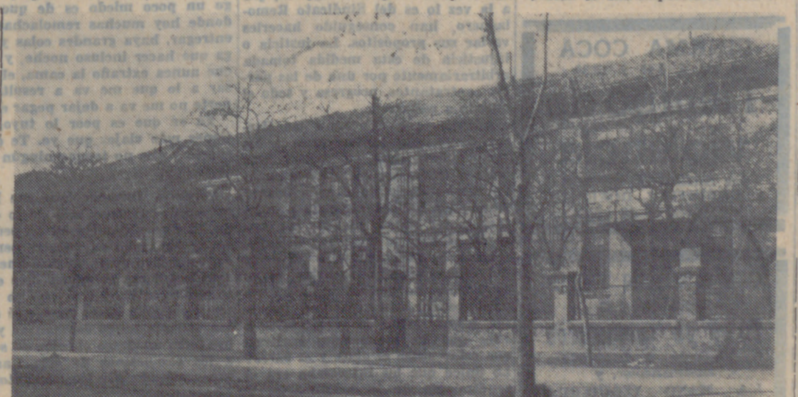
ESCUELAS DEL BARRIO
