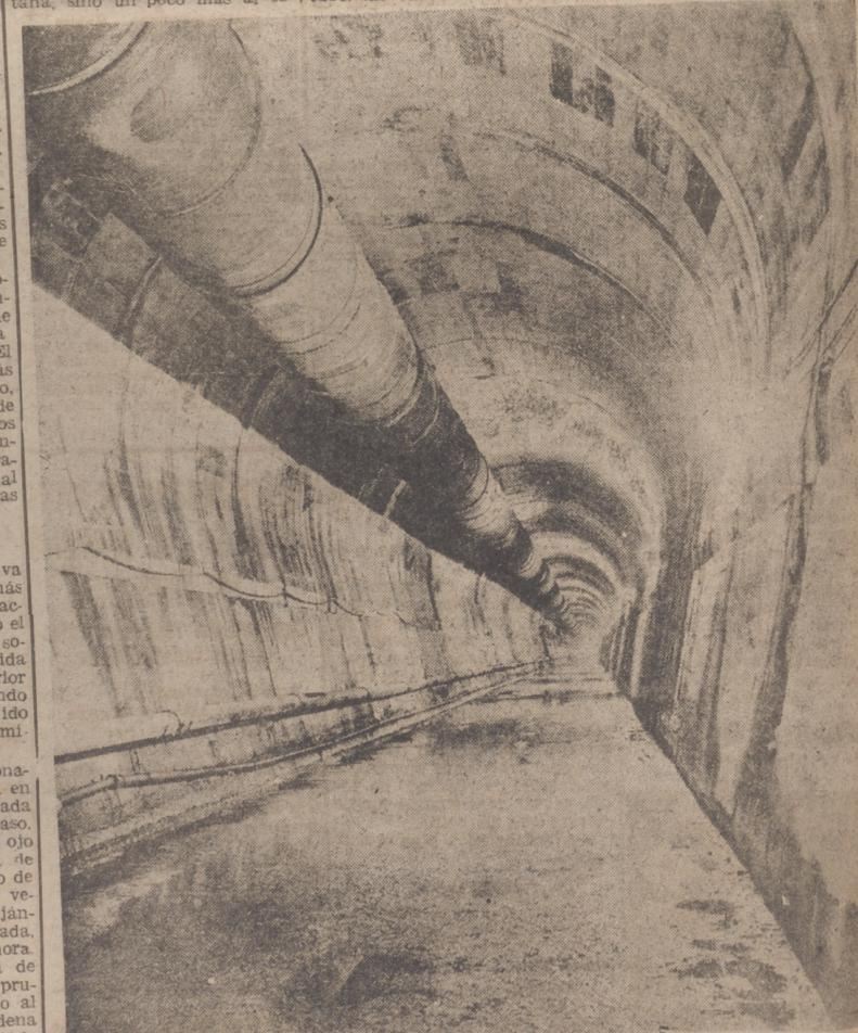
Así se presenta el interior del túnel. La galería, con las paredes pulidas, muestra los focos de iluminación adosados. A cierta altura del suelo, a la izquierda, se ve el tubo de inyección de aire, y en lo alto la conducción de gases nocivos que se extraen del túnel.
