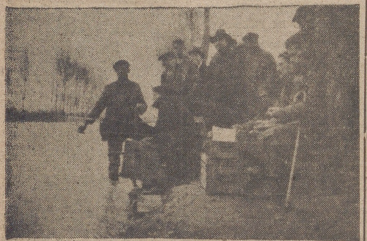
1936. Catástrofe en el Esgueva. Era la segunda del año. De un año en que sobró. El grabado representa una improvisada estación de aforos con un molinete para calcular el caudal que llevaba el infausto río.
