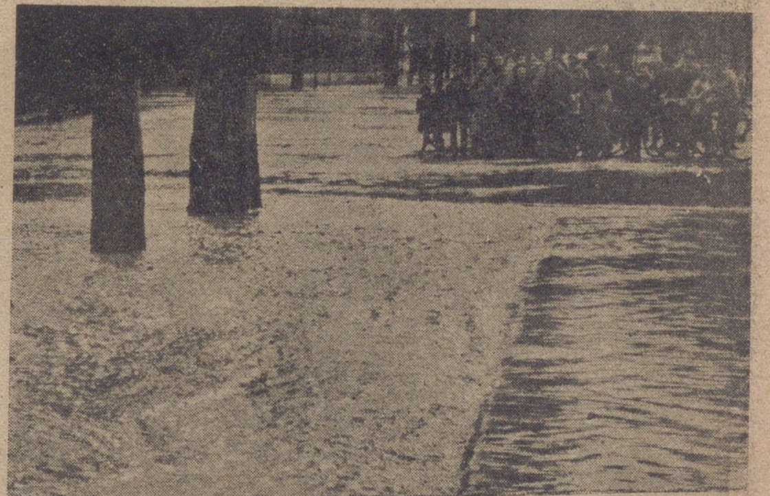
Las aguas del río empezando a saltar la carretera de las Moreras.
