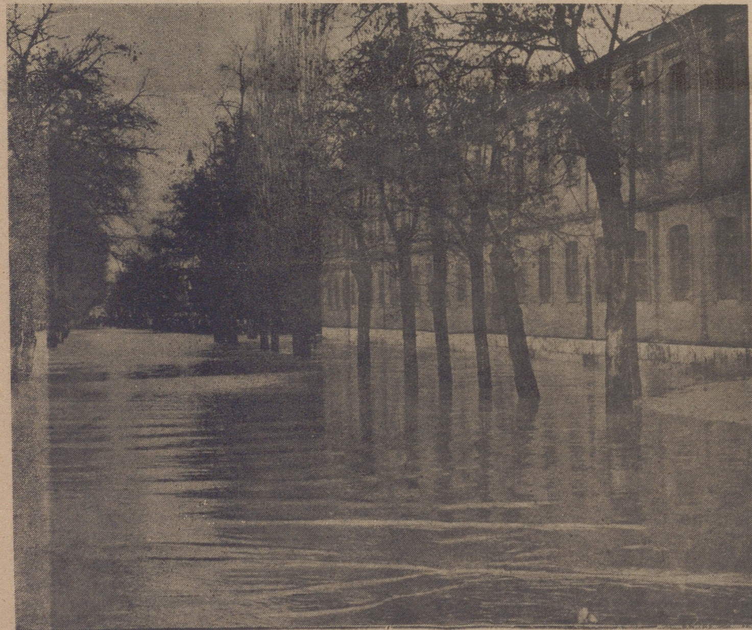
A las dos de la tarde la riada inundó por completo la carretera, quedando cortada la circulación.
