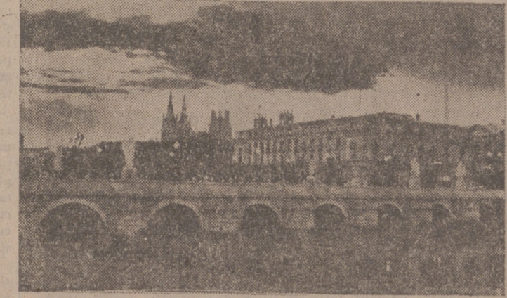
El Puente de San Pablo, reforma que fué llevada a cabo por el Departamento de Obras Públicas.—[Foto Villafraanca.]
