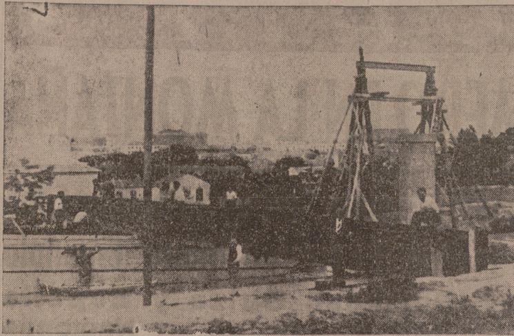
Han comenzado en el Canal de Castilla los trabajos de montaje de la antigua pasarela del Portillo de la Merced. Con esta instalación quedará facilitado el paso de una orilla a otra de nuestro "tercer río", que adolece de esta falta capital. En la foto de Carvajal, una fase de estos trabajos de montaje.
