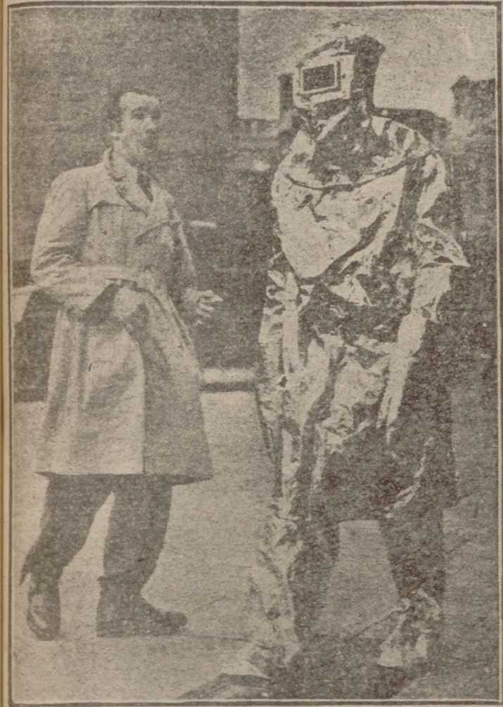
Este caballero del traje de papel de plata se dirige a la Exposición Hortícola de Londres con el fin de someter a diversas y peligrosas pruebas el tejido de su modelo. Se trata de un protector de aluminio, capacitado para resistir temperaturas de 2.300 grados.
