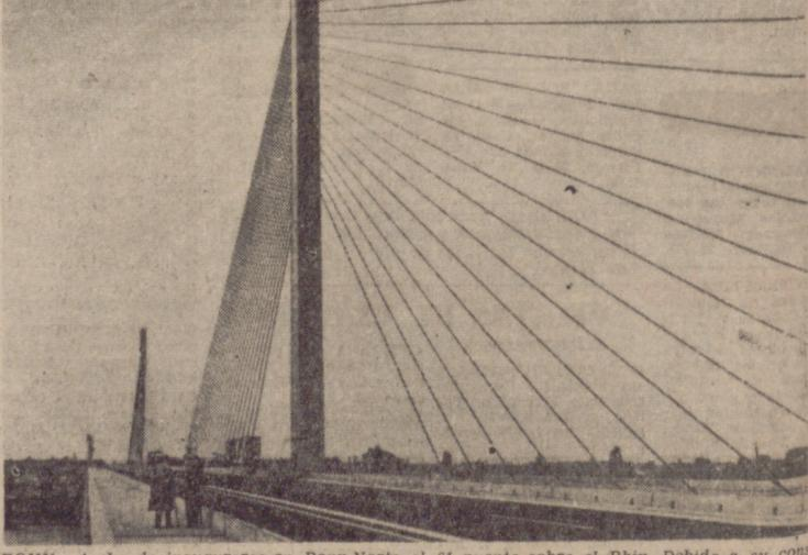
BONN.—Acaba de inaugurarse en Bonn-Norte el 61 puente sobre el Rhin. Debido a su construcción singular y muy moderna, se le llama en el lenguaje popular "el arpa". El puente tiene una longitud de 520 metros, un ancho de 36 metros y cuenta en 80 cables de acero, los más fuertes, los exteriores, tienen un diámetro de 12,3 metros. Los cables están anclados lateralmente en dos pilares de 49 metros de altura.
