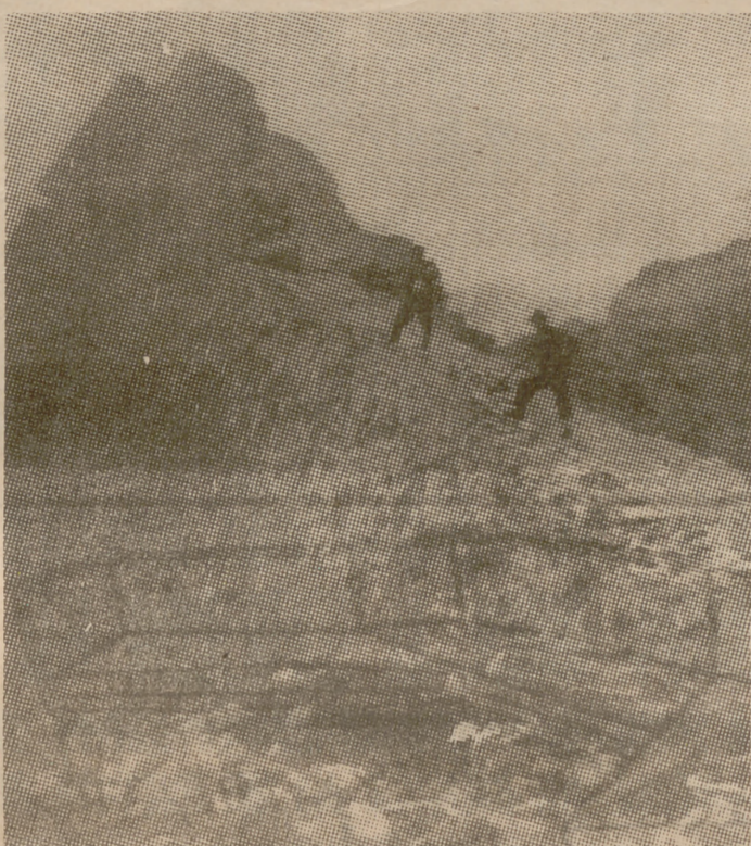
Esta es la presa de Vega de Tera, que muestra el boquete por donde salió el agua y que produjo la catástrofe. (Foto Fiel.)
