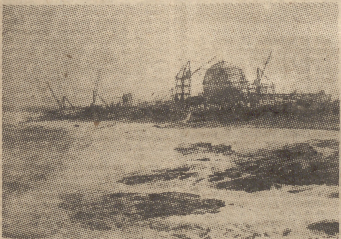
Vista general del nuevo reactor nuclear, que se está construyendo en Dounreay (Escocia). (Foto Europa.)
