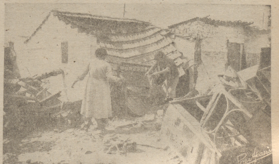
En el tejado de esta casa hicieron trepar un burro... que se salvó de la riada.
