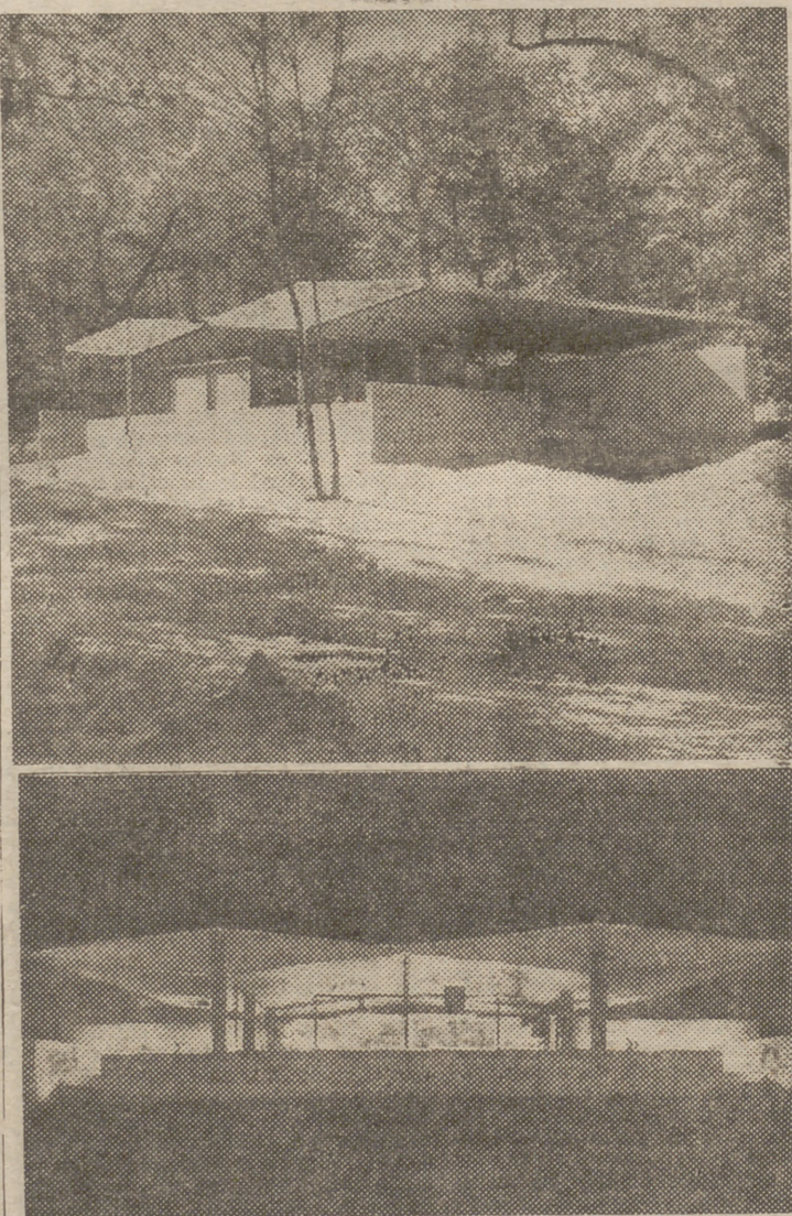
La vivienda de Ulrich Franzen, cuyo propietario es el mismo arquitecto autor del proyecto, es una de las más originales construcciones realizadas en Norteamérica durante el pasado año. Ha sido resuelta cuidando su plástica tanto durante las horas del día como en las de la noche. El cuarto de estar tiene tres de sus lados constituidos por láminas de vidrio, el cuarto es el que comunica con la cocina, dormitorio y aseos. En la planta aparecen marcados con B R los dormitorios; D R es el comedor, y L R el living-room. Las terrazas a ambos lados de la casa están representadas mediante sendos rayados.
