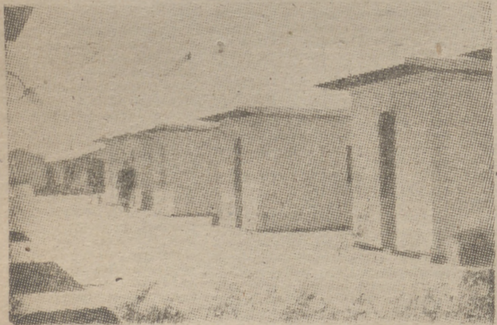
Las casetas de los obreros especializados en Hassi-Messaud.
